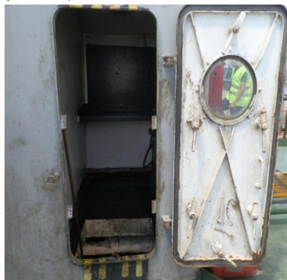
Εικόνα 10: Η πόρτα εισόδου του αντλιοστασίου σε ανοικτή θέση
