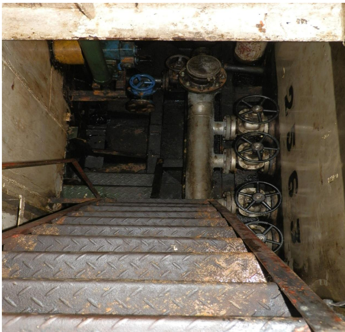
Εικόνα 1: Η κάθοδος της κλίμακας προς το πάτωμα του αντλιοστασίου
